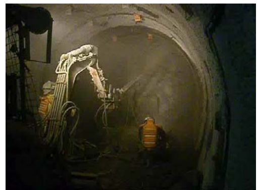
140m研究アクセス坑道を用いた HFSC吹付け試験の様子 (幌延)
