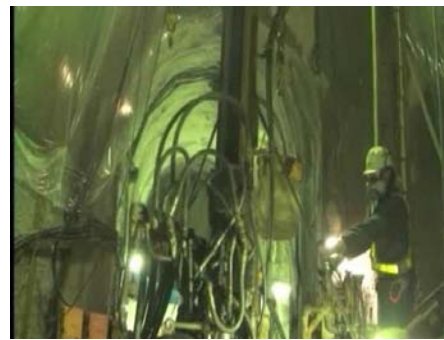
グラウト注入(瑞浪主立坑)
