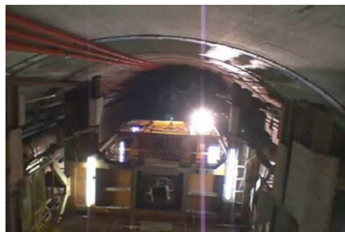
水平坑道建設(瑞浪300m水平坑道)
