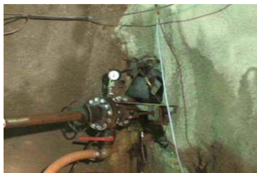
先行ボーリング(瑞浪300m水平坑道)
