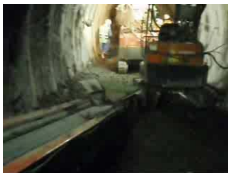
水平坑道貫通(幌延140m研究アクセス坑道)
